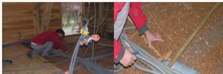
Isolation de plancher avec du liège
