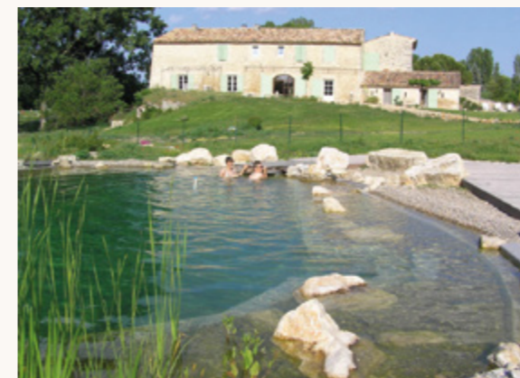
Piscine naturelle G14391 (Alpes de Haute-Provence) La Bastide à CERESTE
